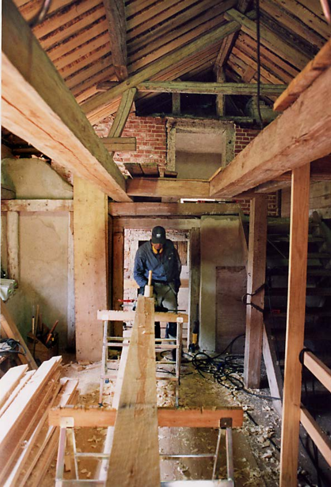
Under hela renoveringsarbetet skräddades allt nytt virke till väggar och bjälkar för hand på arbetsplatsen. Mattias Forsberg i arbete. Okt. -08.
