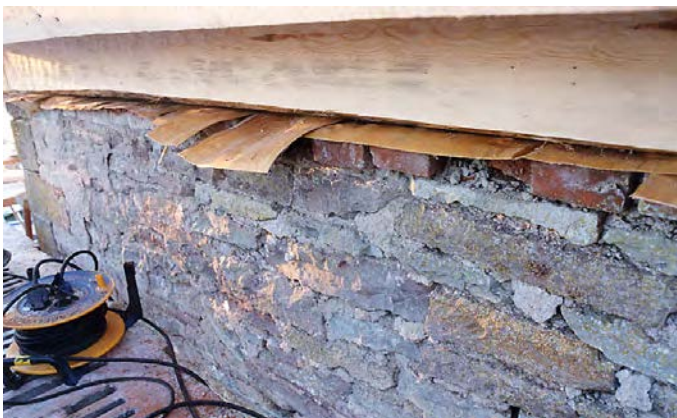
Där timret vilar på tegel eller sten läggs ett fuktisolerande lager näver som skydd. Nov 2002.
