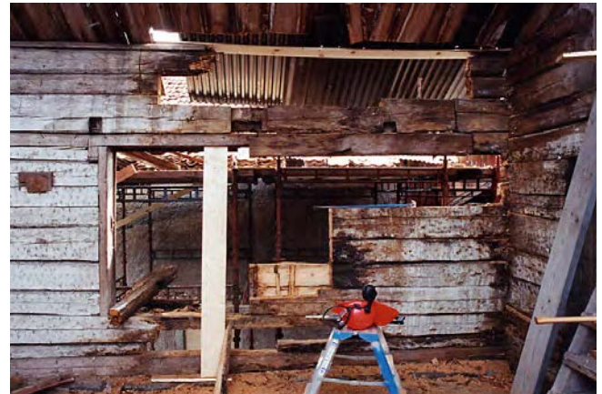
Allt rötskadat virke togs bort i östra väggen på magasinsutrymmet. Sep. 2002.
