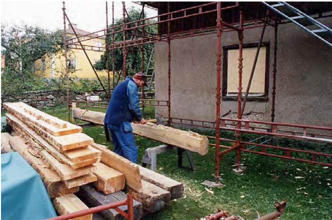
Allt tillverkningsarbete skedde på gården vid mejeriet. Mattias Forsberg skrär en stock för lagning av östra väggen i köket. Sep 2002.
