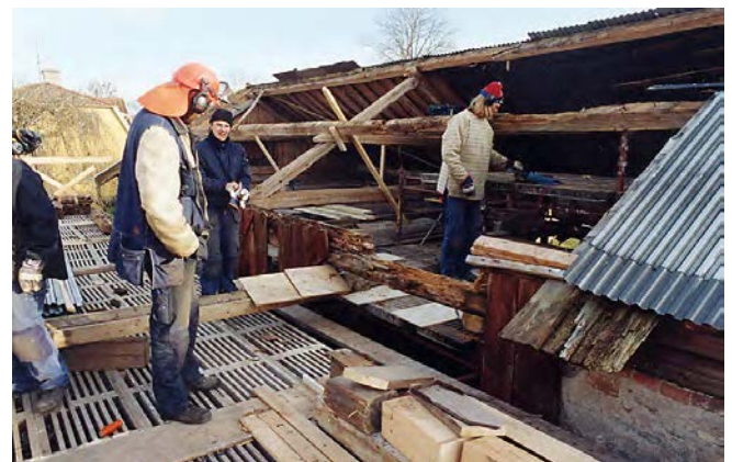
Taket på östra huset var om möjligt ännu sämre än på det västra. Förutom takpanel och väggtimmer (hammarband + en stock - detta hus är murat) byttes flera åsar i taklaget. Nov. 2002.
