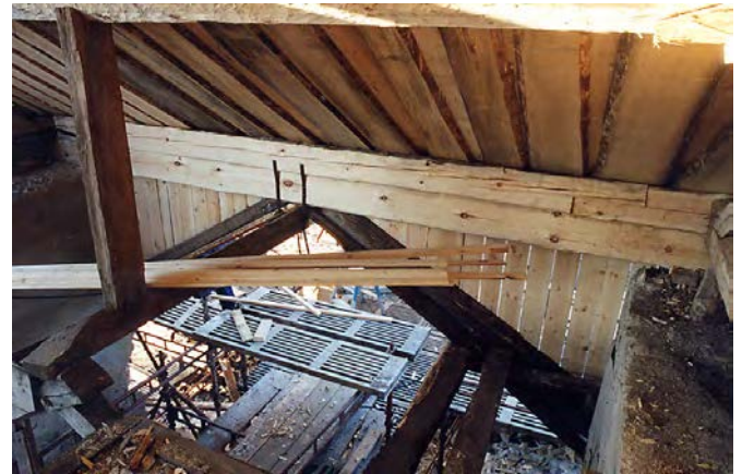
Nya hammarband i östra huset. Dec. 2002.
