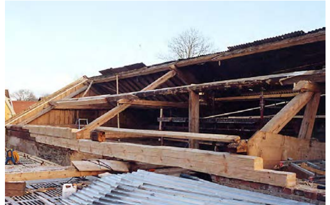
Byte av åsar (den närmaste) och förstärkning med plank (den bortre). Nya hammarband vilar på ett par utjämnande tegelskift. Nov. 2002.
