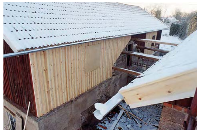
När alla timmerlagningar var avslutade, kläddes husen med ny ramsågad panel och takteget lades tillbaka, med komplettering. Urtag i panelen lämnades för det kommande "mellanhuset". Dec. 2002.
