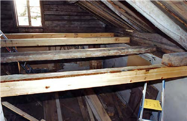
Byte av takbjälkar över köket i västra huset. Nov. 2002.
