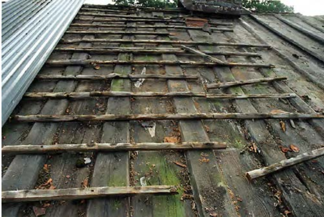
Taket bestod av okantade bräder på lock där underbräderna var spårade med hyvlade vattenrännor.
